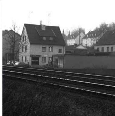
Der Betrieb in den Siebzigern
